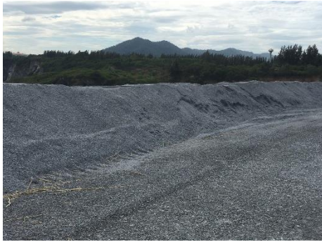
รูปที่ 2-35: ค้นทำนบดินและคูระบายน้ำบริเวณขอบบ่อเหมืองด้านที่ติดกับโรงโม่หิน
