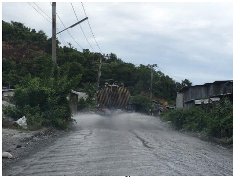
รูปที่ 2-14: การฉีดพรมน้ำบนเส้นทางขนส่งแร่
