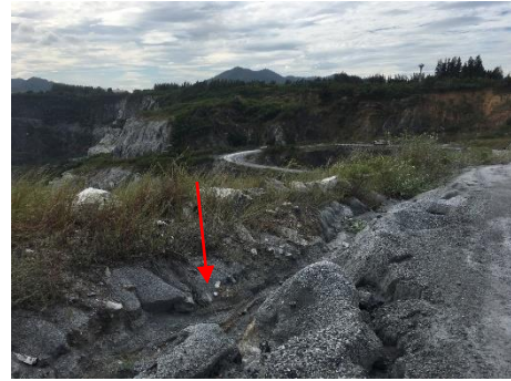
รูปที่ 2-35: ค้นทำนบดินและคูระบายน้ำบริเวณขอบบ่อเหมืองด้านที่ติดกับโรงโม่หิน
